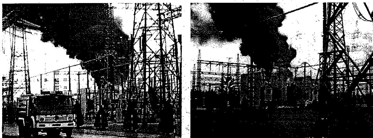
HÌNH 14. SỰ CỐ CHÁY NỔ TRẠM BIẾN ÁP ĐIỆN TẠI ĐÀ NẴNG
